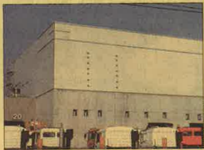
Die neue Halle ist fast fertig
